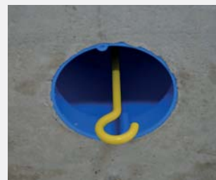
6. W puszcze można osadzić również hak do podwieszania (P533 lub P534). Po zalaniu betonem szalunku i wyschnięciu, usuwa się szalunek i na powierzchni sufitu zostaje wtedy czoło puszki z wystającymi końcówkami gwoździ. Tą wierzchnią pokrywą wybijamy młotkiem odsłaniając wnętrze puszki pod wkręcenie haka i instalację.
