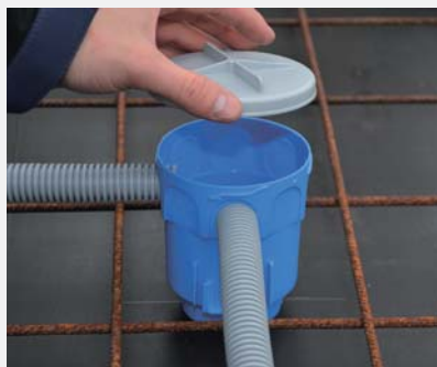
2. Podłącz w odpowiednich miejscach rury.
