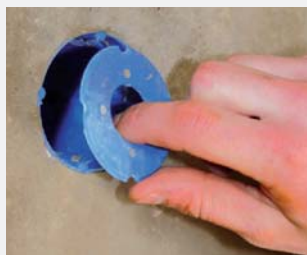
5. Wybić dekielek dla odkrycia przestrzeni do zamocowania osprzętu
