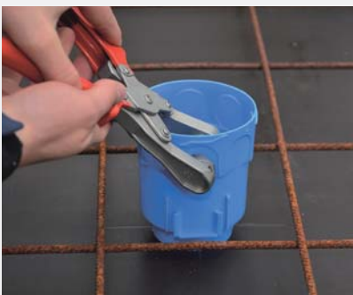
1. Wytnij osłabienia, po przybiciu do szalunku.
