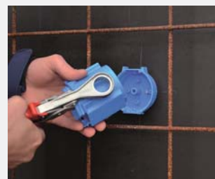
2. Wytnij w żądanych miejscach osłabienia pod rury
