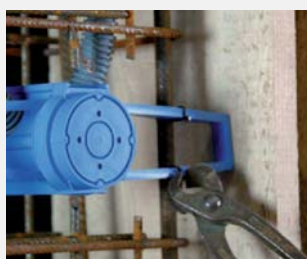
3. Skrzydło puszki przymocować drutem do zbrojenia.
