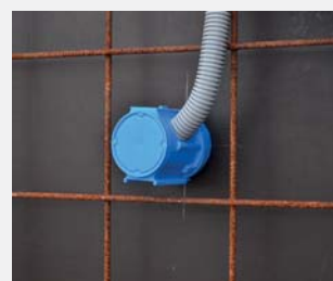
4. Osadź rurę w wyciętym otworze.
