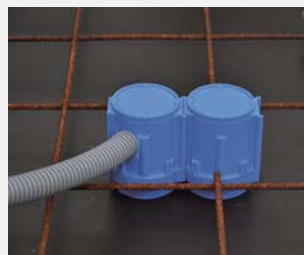
5. Można przybić do szalunku dodatkowe denko do osadzania kolejnych puszek w układzie ramkowym 71mm.
