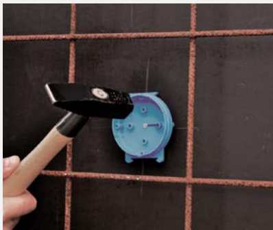
1. Przybić puszkę do szalunku (lub z uchwytami P418), przymocować do zbrojenia).
