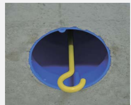
6. Przykład zastosowania puszki w układzie sufitowym z hakiem montażowym P533. Po zalaniu betonem szalunku i wyschnięciu, usuwa się szalunek i na powierzchni sufitu zostaje wtedy czoło puszki z wystającymi końcówkami gwoździ. Tą wierzchnią pokrywę wybijamy młotkiem odstaniając wewnątrz puszki pod wkręcenie haka i instalację.
