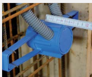
4. zamocowana puszka pozwala na wylewkę betonu do głębokości 6 cm.
