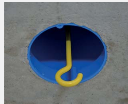
6. Opcjonalne użycie długiego haka do powieszania (P534). Po zalaniu betonem szalunku i wyschnięciu, usuwa się szalunek i na powierzchni sufitu zostaje wtedy czoło puszki z wystającymi końcówkami gwoździ. Tą wierzchnią pokrywą wybijamy młotkiem odslaniając wnętrze puszki pod wkręcenie haka i instalację.
